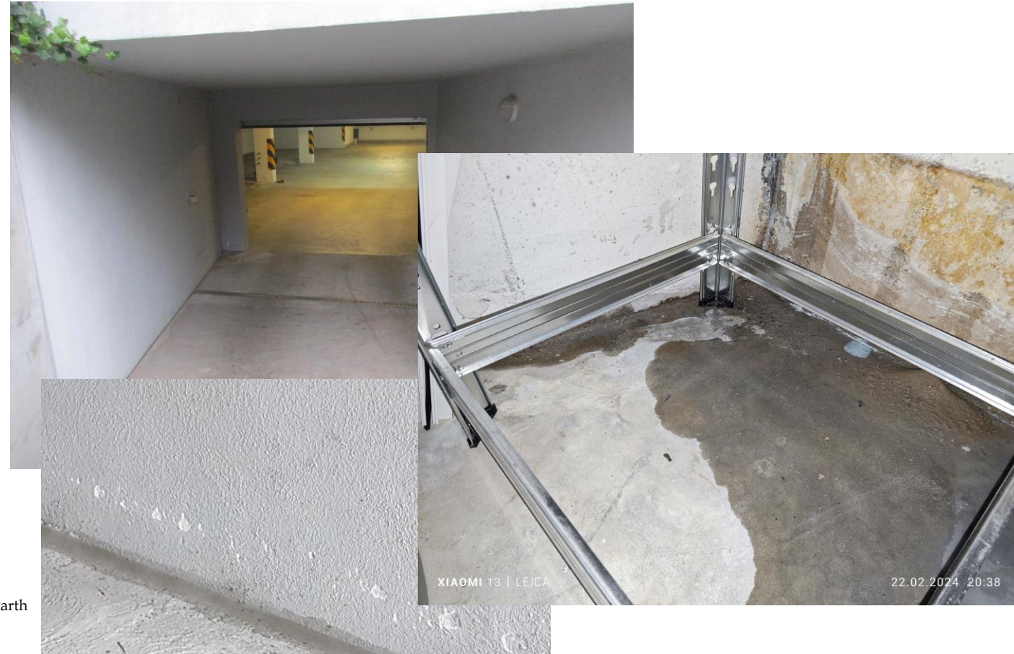
Erscheinungsbild nach Betoninstandsetzung und Abdichtung mit einem OS10
