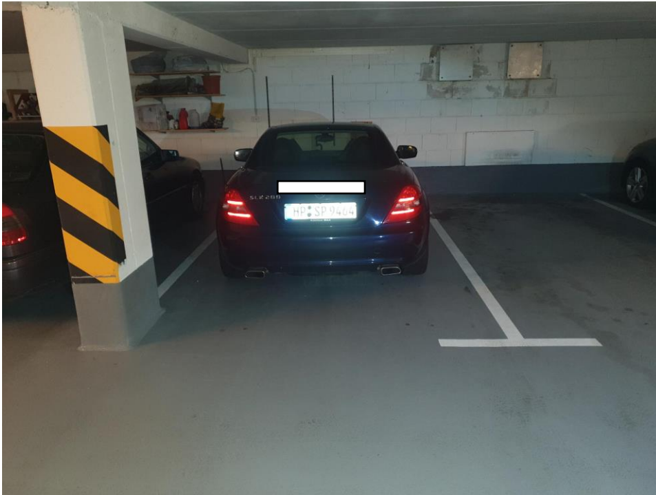
Erscheinungsbild nach Betoninstandsetzung und Abdichtung mit einem OS10
