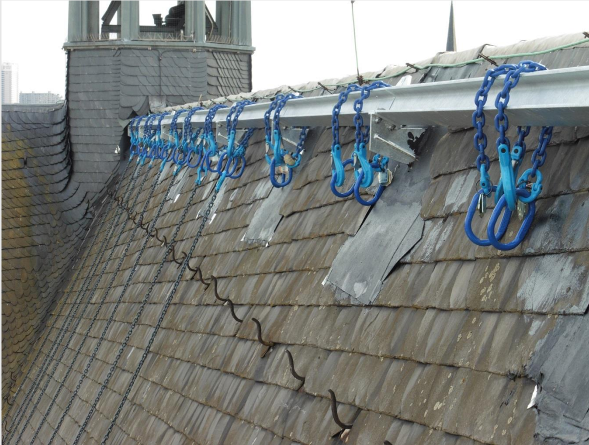
Konsole mit Längsträger und Ketten nach Einbau
