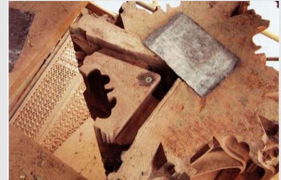
© aus Sanierung des Westturms Hochbauamt
