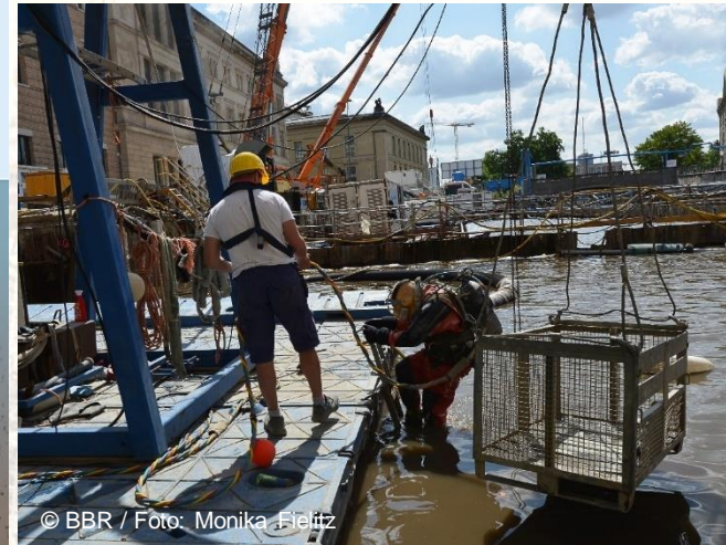
Tauchgang zur Entfernung des Überprofils
