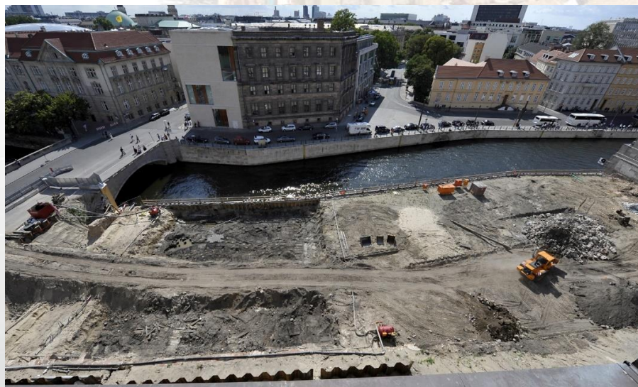
Baufeldfreimachung und Voraushub © BBR / Foto: Monika Fielitz
