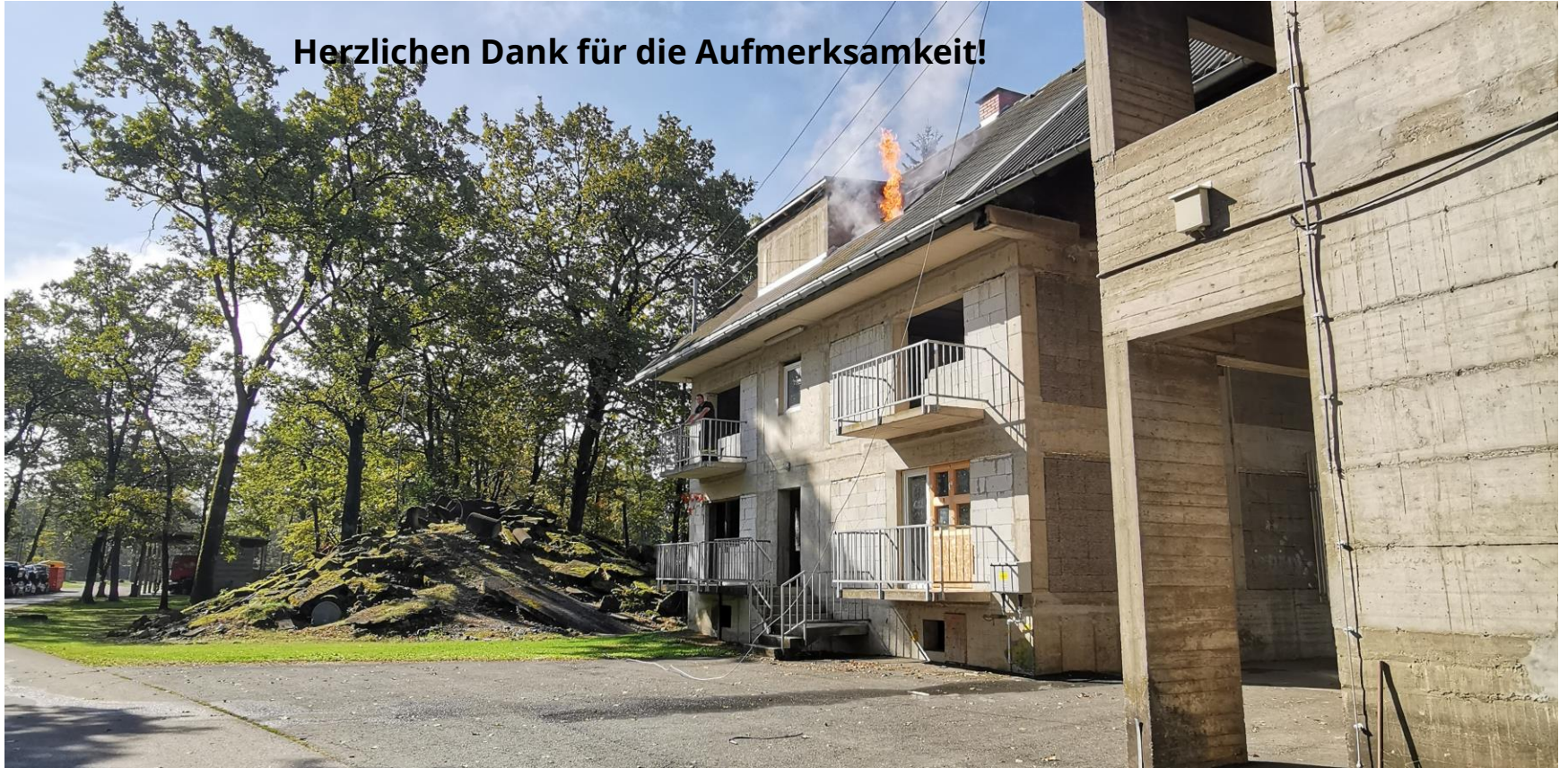
„Brandhaus“ am Gelände der Feuerwehrscheule Lebring; © blp GeoServices GmbH
