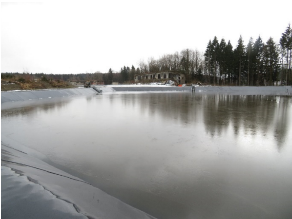
Abb 7: Foto Rohwasserbecken (RB1) (Quelle: Landkreis Goslar)
