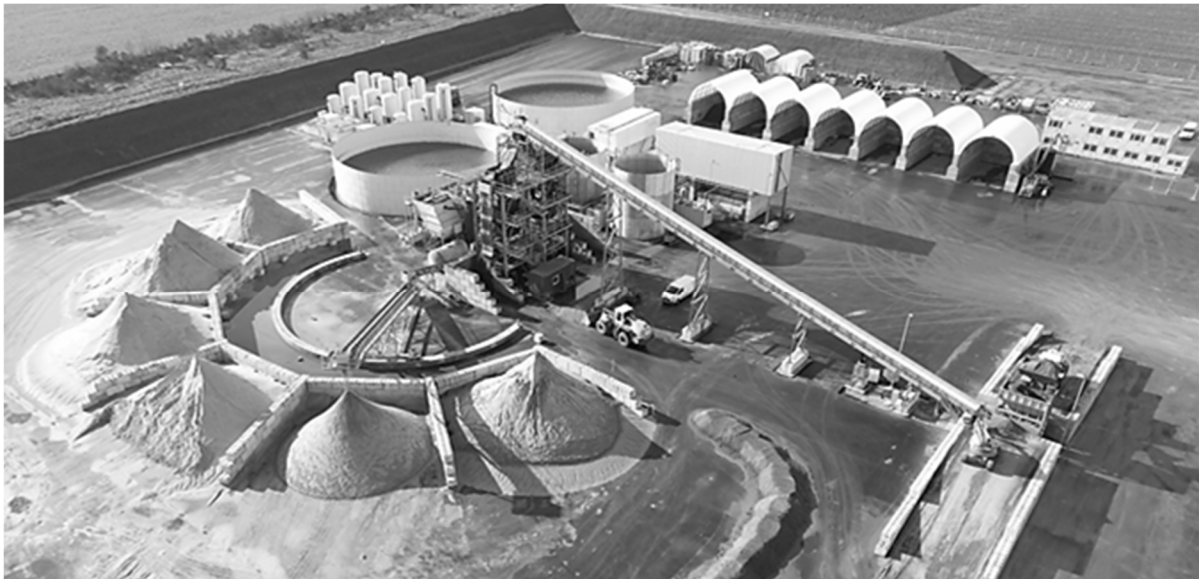
Abbildung 1: Luftaufnahme der PFAS-Bodenreinigungsanlage in Norddeutschland.
