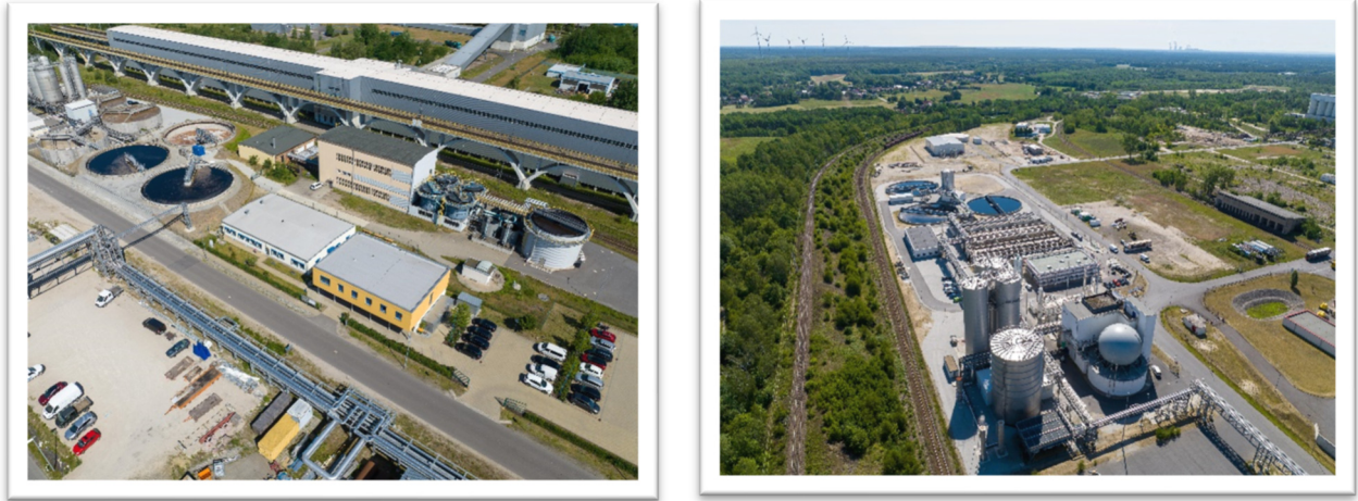
Abbildung 9: Abwasserbehandlungsanlage mit ZV ISP
