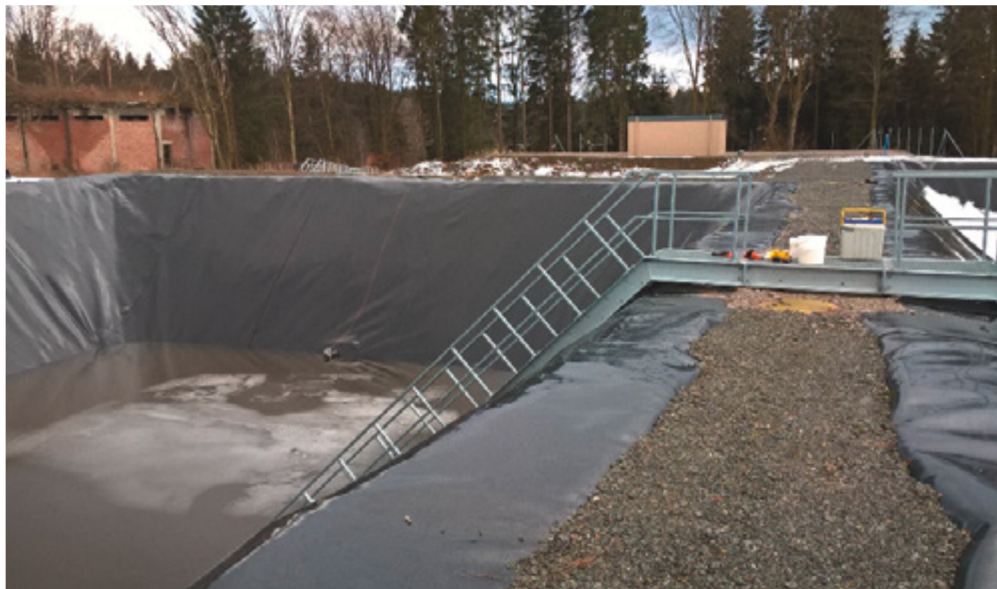
Abb. 10: Foto Sedimentationsbecken (SB1) (Quelle: IABG)
