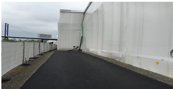
Abbildung 7: Abdichtung bestehende Halle
