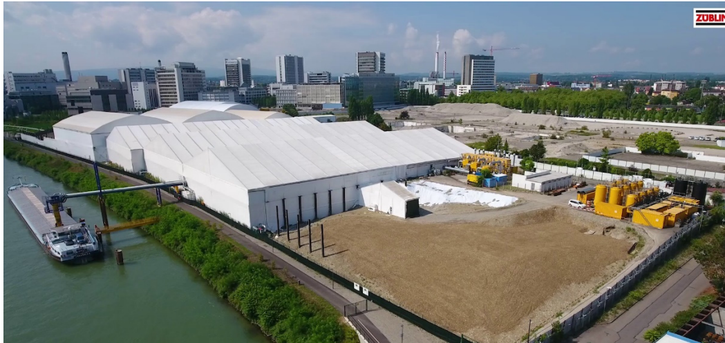
Abbildung 14: Ansicht Gesamtprojekt mit erster sanierter Fläche und Schiffsverladung
