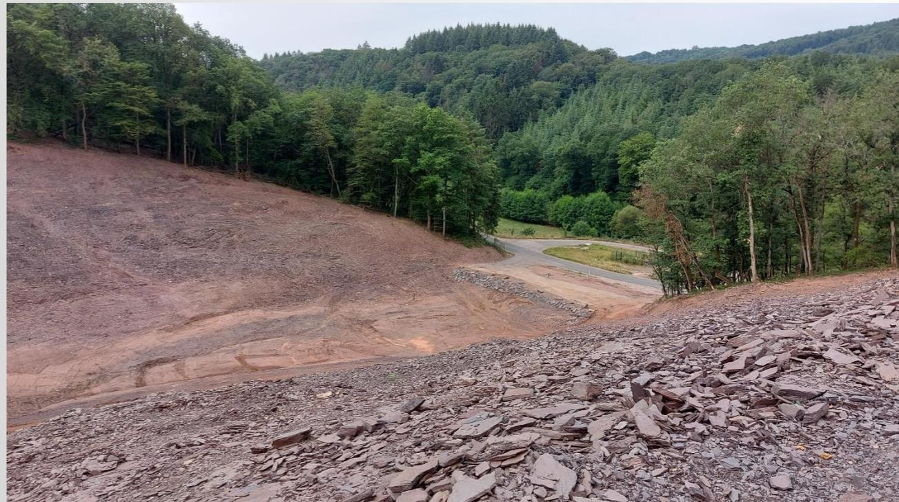
Nach Freilegung zeigen sich die [Grundwasseraustritte an den Flanken und der Sohle](#), die zuvor in den Abfall flossen und Sickerwasser erzeugten.
