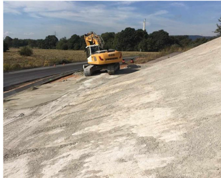
GPS 0/8mm Einbau mit d > 20\text{cm} , D_{pr} > 97\% ( 5 \cdot 10^{-9} \text{ m/s} )
