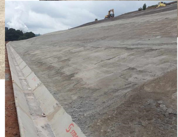
GPS 0/8mm Einbau mit d > 20\text{cm} , D_{pr} > 97\% ( 5 \cdot 10^{-9} \text{ m/s} )
