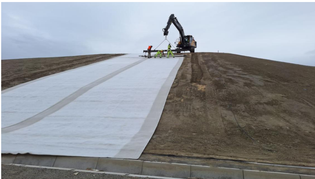
Abbildung 5: Testfeld der Sonderabfalldeponie Gera-Aga mit Bentofix® B 13000
