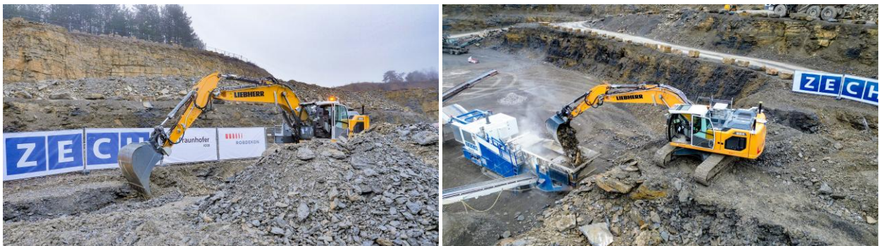
Abbildung 8: Beispielbilder vom autonomen Bagger ALICE im Steinbruch. Als relevante Umgebung für autonome Arbeitsmaschinen Teil des GOOSE-Datensatzes.
