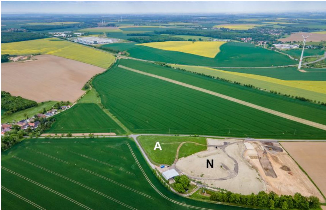
Abbildung 1: Luftaufnahme der Sonderabfalldeponie Gera-Aga mit Altteil (A) und Neuteil (N)
