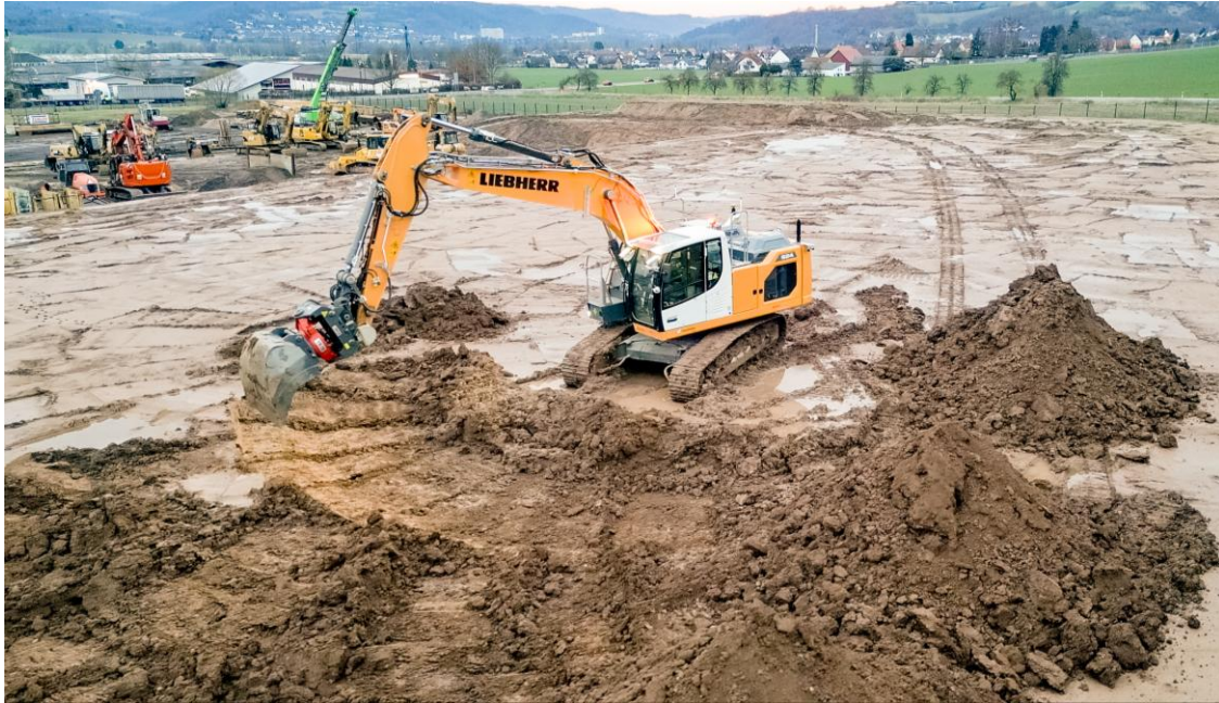
Abbildung 9: Bagger ALICE führt autonomen Aushub durch. Die entstandenen Erdgeometrien gehen in den Datensatz mit ein, ebenso wie andere auf dem Gelände befindliche Baumaschinen.
