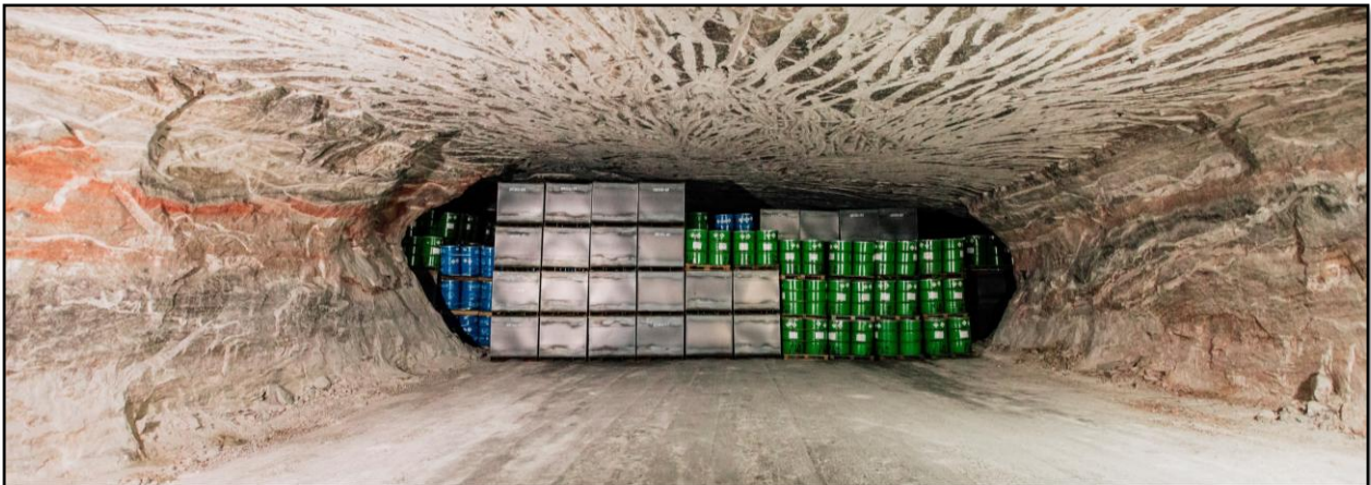
Abbildung 2: Einlagerungsbereich für gefährliche Abfälle in der Untertagedeponie Herfa- Neurode
