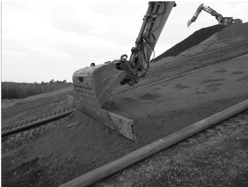
Abbildung 33: Einbau von Trisoplast® mit Abziehlehre, Quelle: STRABAG Umwelttechnik GmbH
