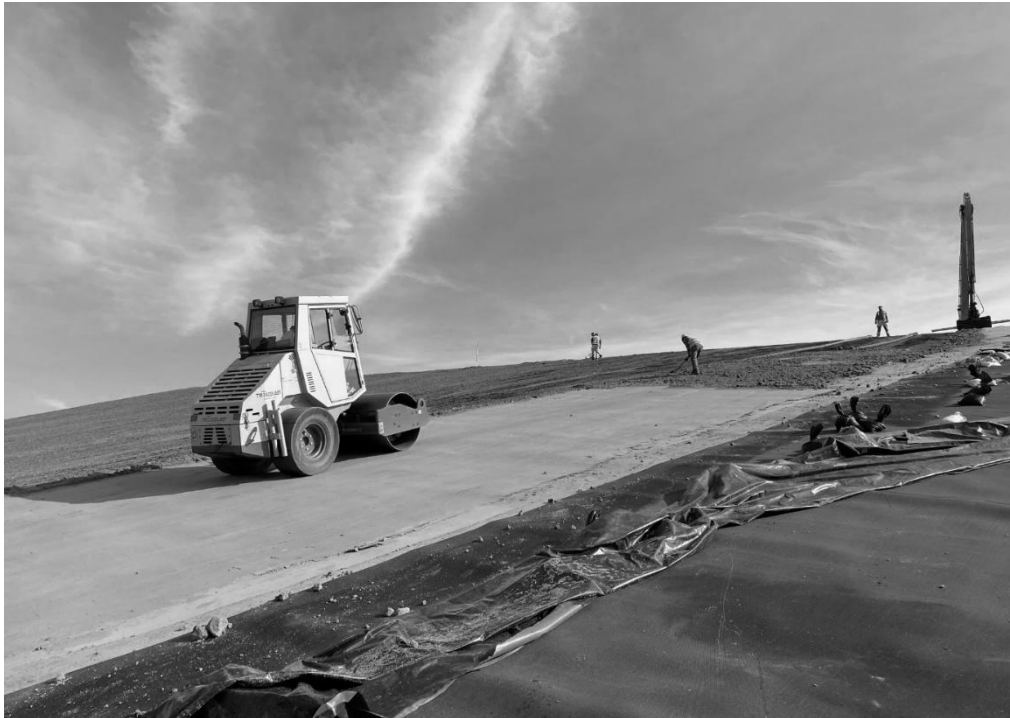
Abbildung 34: Abwalzen der Trisoplast®-Dichtung mit einer leichten Glattmantelwalze, Quelle: G quadrat GmbH
