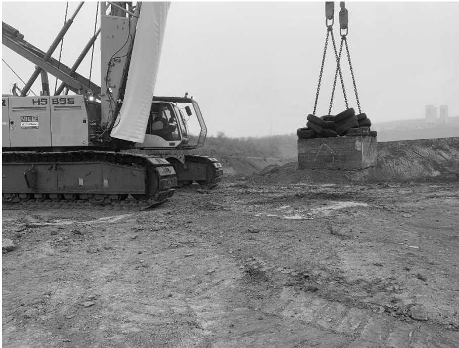
Abbildung 25: Seilbagger mit Fallgewicht (Quelle: Franz Kassecker GmbH, 2024)
