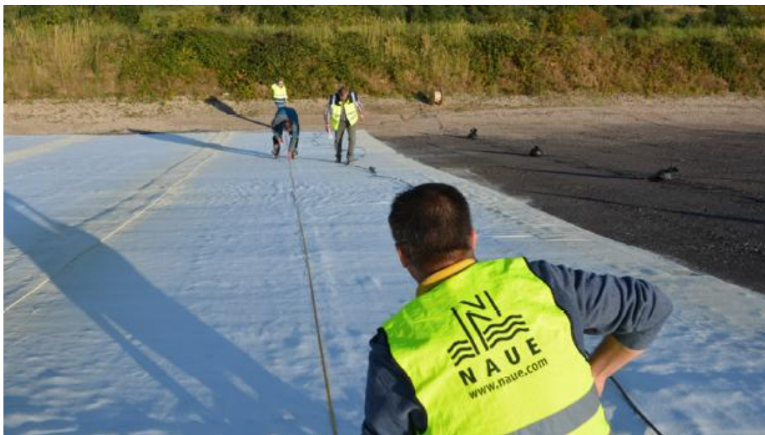
Abbildung 4: Testfelder mit Bentofix® B 13000 in Kombination mit DKS – in Bildmitte mit DKS auf Bentonitmatte, am rechten Bildrand mit DKS auf Planum
